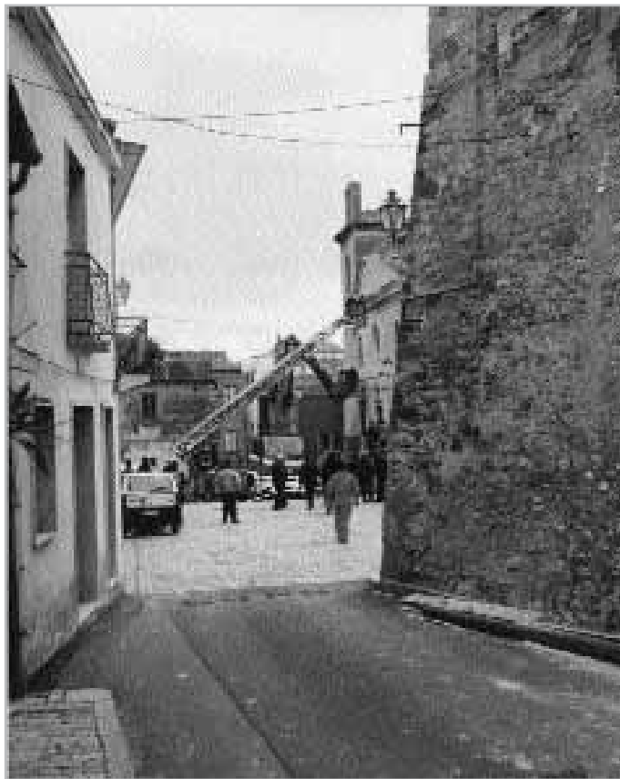
Lavori di puntellamento a Macchia Valfortore
